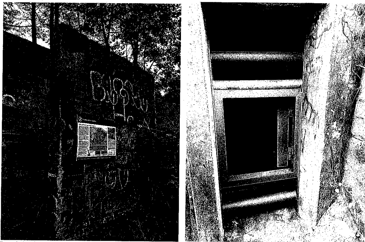
Fot. 1. Tablica na ścianie schronu, Fot. 2. Zabezpieczone wejście do zimowiska (Fot. E. Sobańska)
